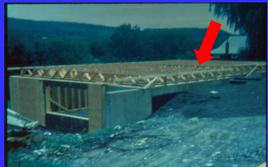
TYPE V DESIGN--PLATFORM FRAME
